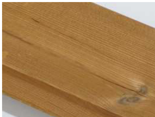
Malé podélné trhliny na povrchu jsou povoleny.
