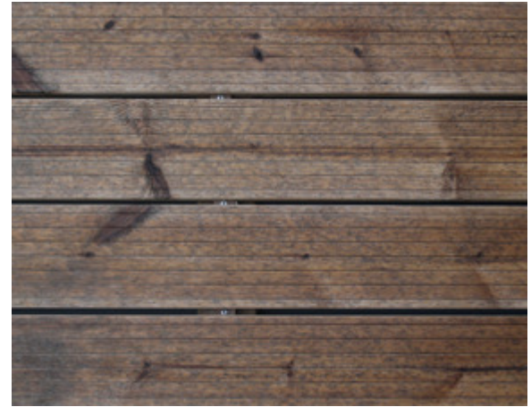
Terasové profily vo fáze začínajúceho procesu šednutia. (prirodzené sú mapky pripomínajúce vznikajúcu pleseň)
