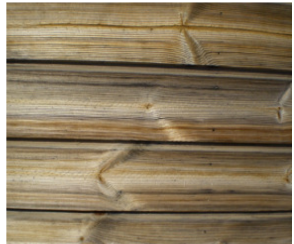
Fasádny obklad v priebehu procesu starnutia (prirodzené sú nerovnomerné farebné zmeny)
